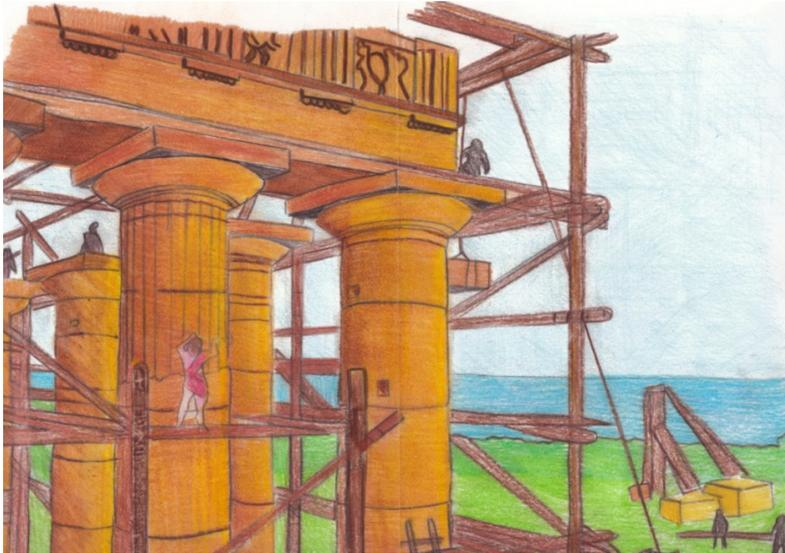
Questo disegno rappresenta una delle ultime fasi di lavoro di costruzione di un tempio e ritrae gli **scalpellini** mentre provvedono a rifinire tutti i dettagli decorativi, come le sculture delle metope e le **scanalature delle colonne**, cioè gli incavi verticali nei blocchi cilindrici (rocchi). Un lavoro, indubbiamente, di precisione e molto faticoso ma fondamentale nella costruzione di un tempio, che esprime le abilità artistiche e le competenze estetiche degli antichi greci.
