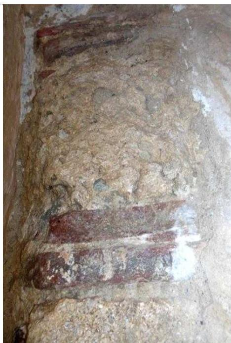
**Figura 9 - Brano di muratura in *opus mixtum* che caratterizza un arco della campata centrale.**
